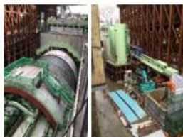
シールド工事
