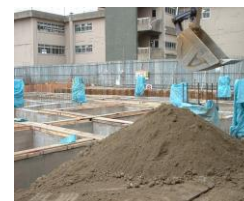
建築基礎埋戻し
